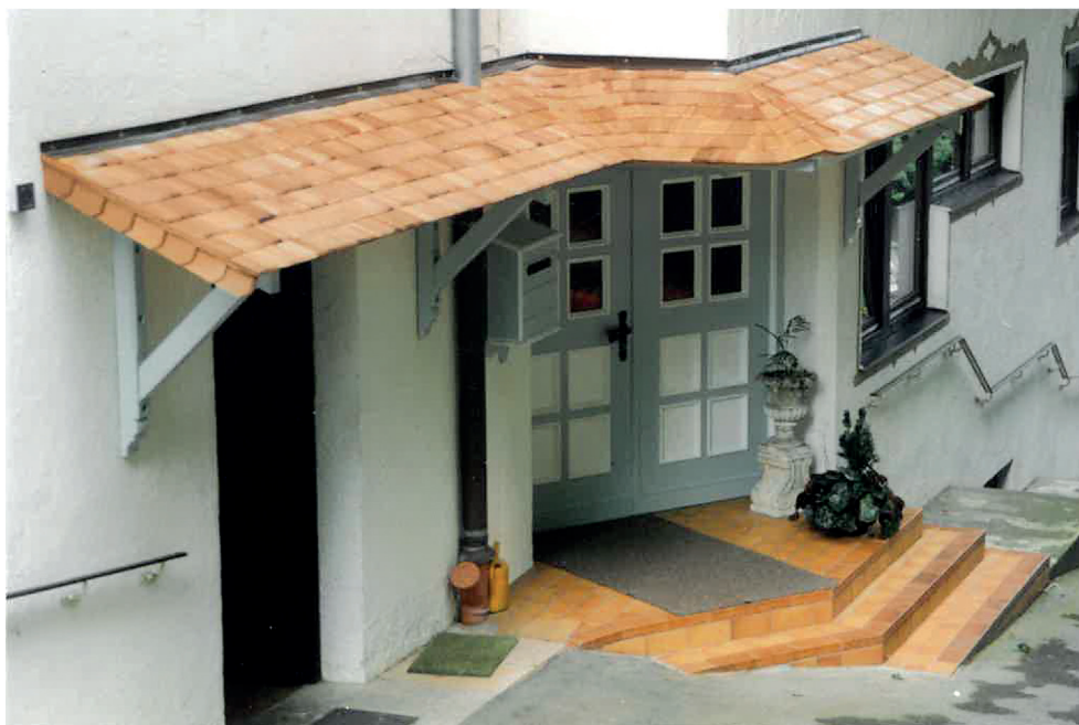
Gespaltene Lärchenschindeln 40 cm lang, 3-lagig im Reihenabstand von 12,5 cm gedeckt
